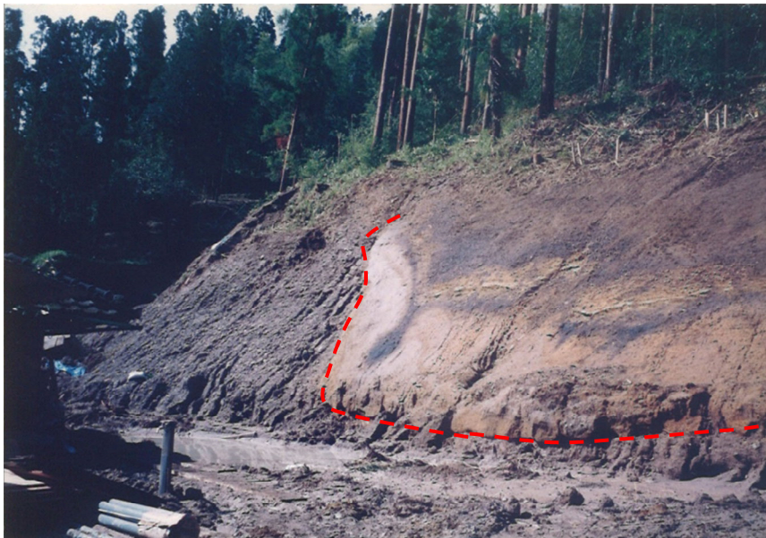
図-9 古い崩壊跡に堆積し降下火砕物(K-Ah・km)など破線分で以前崩壊が発生していたと考えられる。
