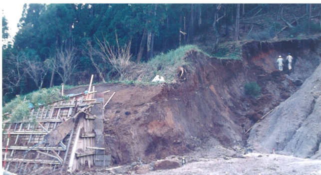
図-2 2回目の崩壊部 深さ 2.5m
