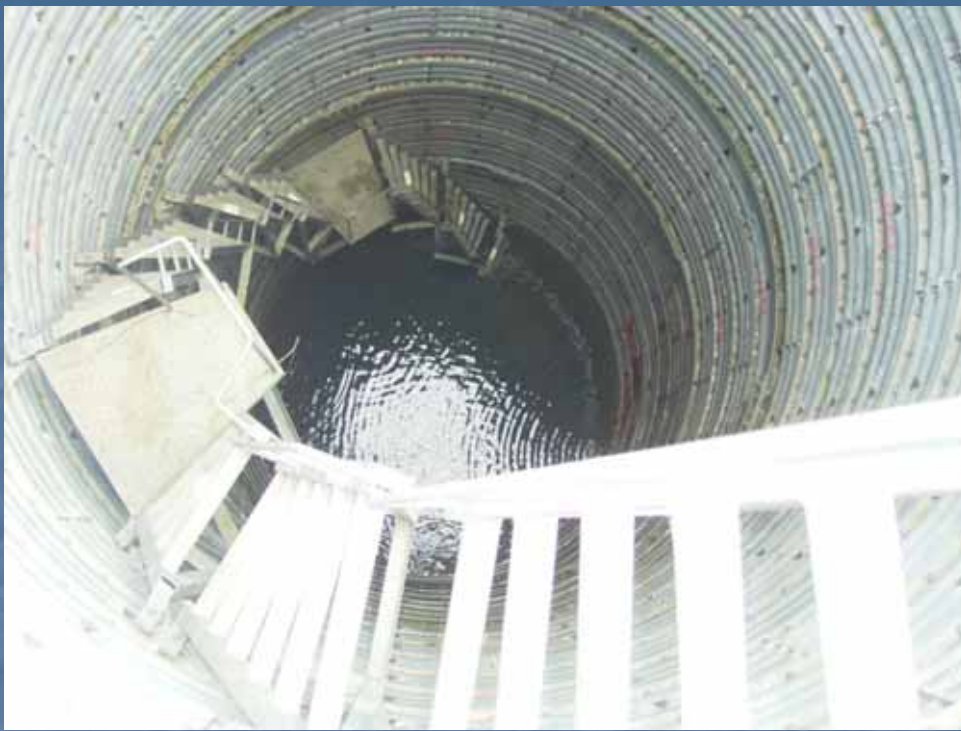
集水井WB-5の貯留状況
