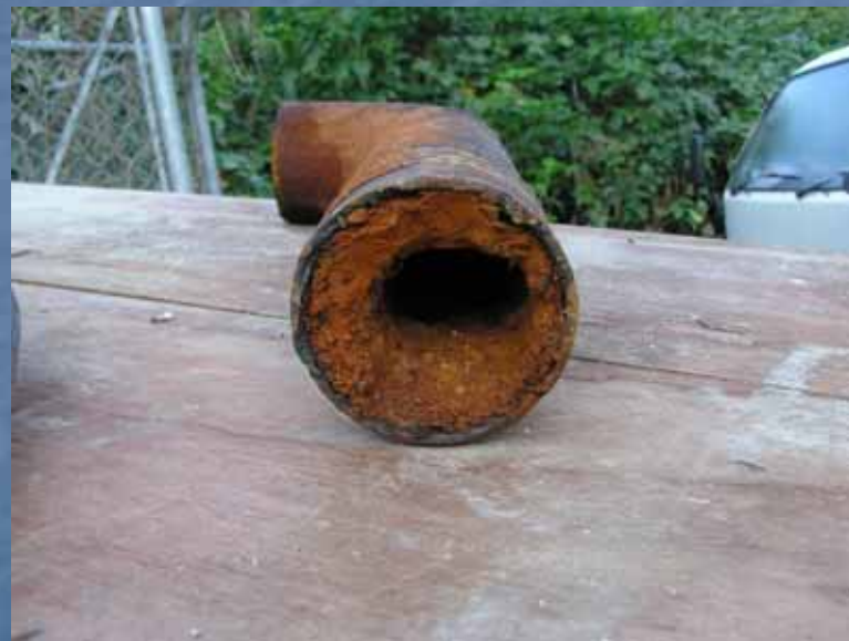
排水管の閉塞状況
