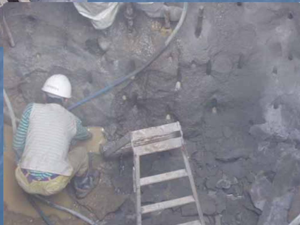
写真12. 工事施工状況写真(3)
