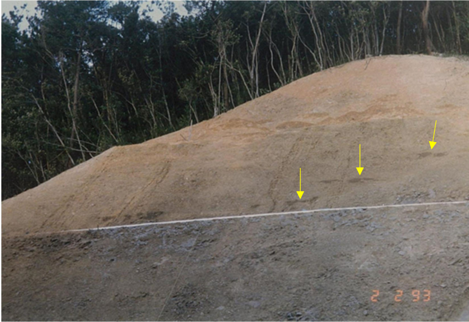
写真⑥ 断続的に湧水箇所がある
