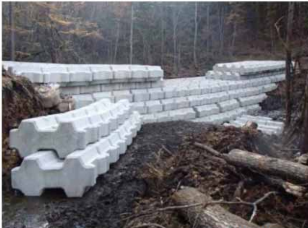
コンクリートブロック積み砂防堰堤 (鹿ノ瀬川、国土交通省中部地方整備局)
