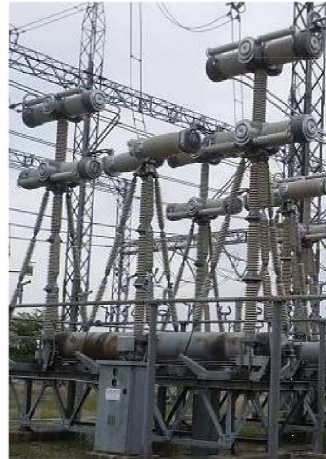
275kV空気遮断器(ABB)
