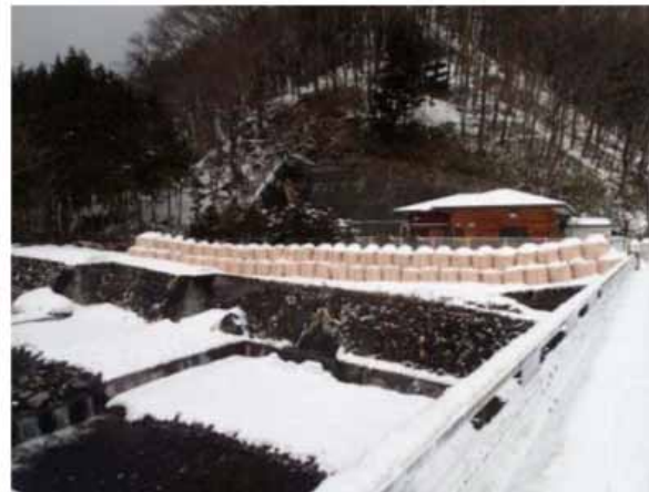
大型土のうによる護岸の嵩上げ (鈴ヶ沢、長野県)
