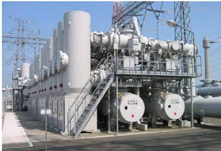
550kVガス絶縁開閉装置(GIS)
