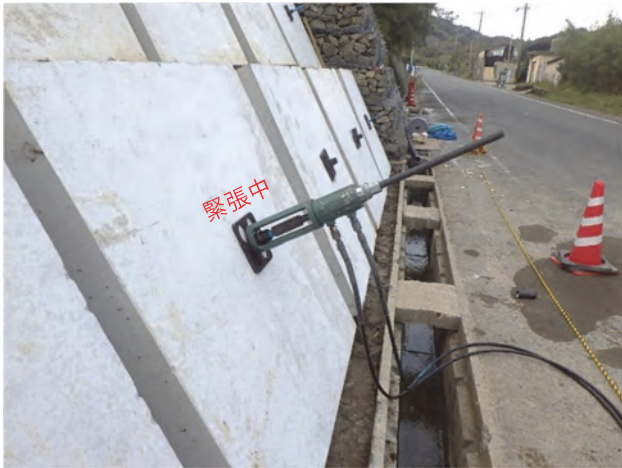
D25 補強材の場合 72KN で緊張
