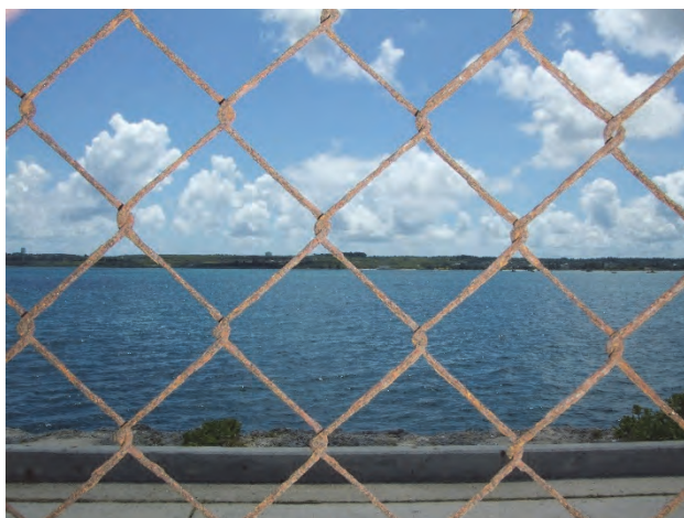
施工後 7 年 メッキ金網 Z-GS-7 Z-GS-7 は、メッキ量 380 (g/m 2 ) で Z 規格最大のメッキ量
