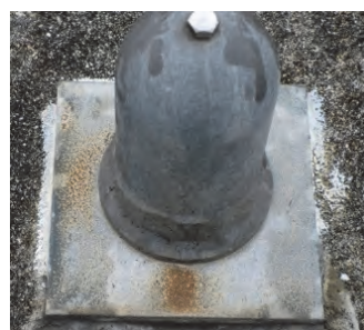
20年経過した海岸部のメッキ
