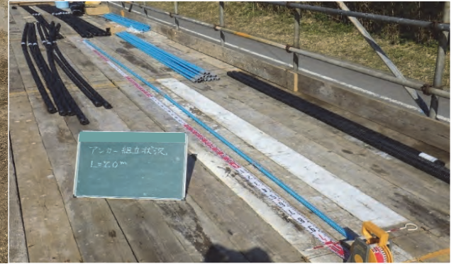
L=7.0mの補強材（青）と波型ポリエチレン管（黒）
