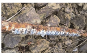
穴曲がり 補強材が孔壁と密着し錆びる
