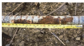
補強材挿入後の孔壁崩壊による錆びと断面欠損
