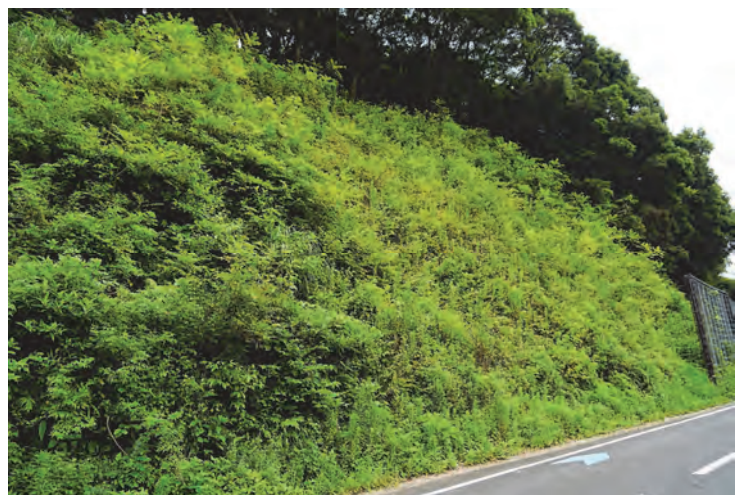
左写真現場の1年後の状態 (鹿児島県)
