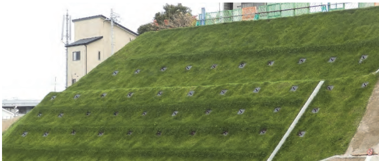
住宅密集地の斜面崩壊箇所での適用例 世紀を超えて、斜面の安定が必要な現場の実施例
