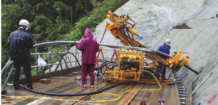
炭素繊維ケーブル挿入工事中
