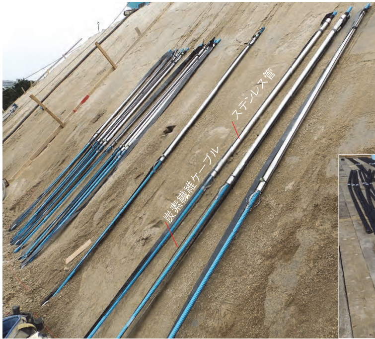
挿入前の補強材
