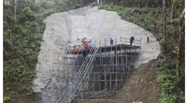
長尺補強土工事中
