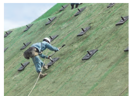
緊張力導入中 緊張後キャップ内に防錆のため エポキシ樹脂を注入
