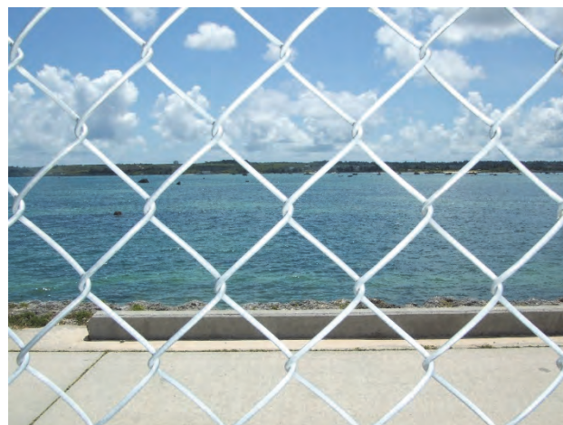
施工後 6 年 IR 被覆鉄線金網（長寿金網と同じ素材）
