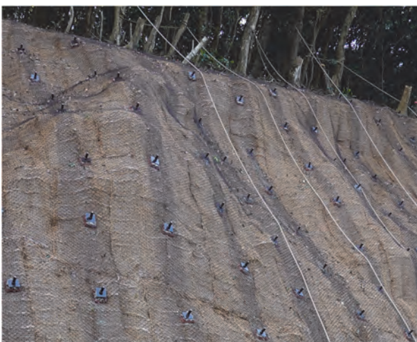
植生誘導マットを金網の下に敷設した事例
