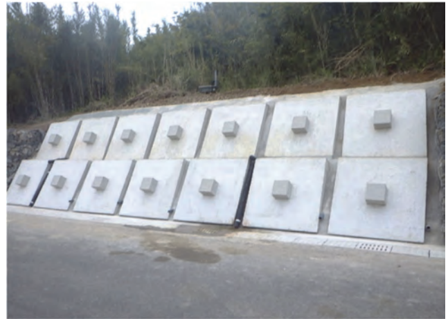
アンカー的な施工例
