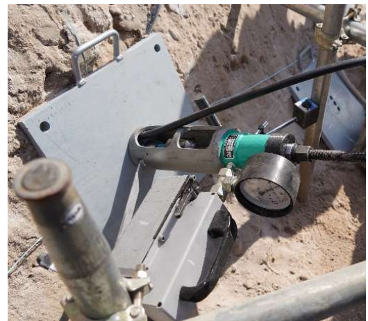
Φ65 mm削孔で緊張しながら二次注入中
