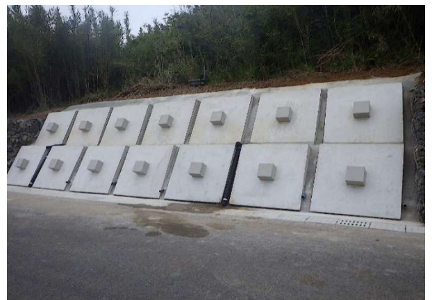
完成後 旧型のアンカー現場のように見えますが、非常 に高耐久性の補強土適用現場です。
