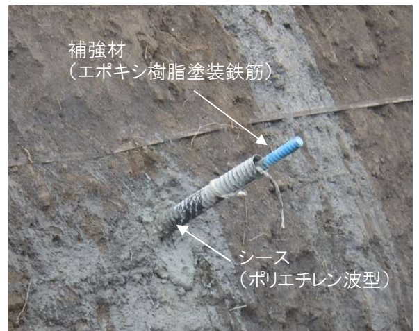
補強材 防食シース内外のグラウトと、全長に配置され たシース、エポキシ樹脂塗装鉄筋が複合的に防 食効果を発揮します。
