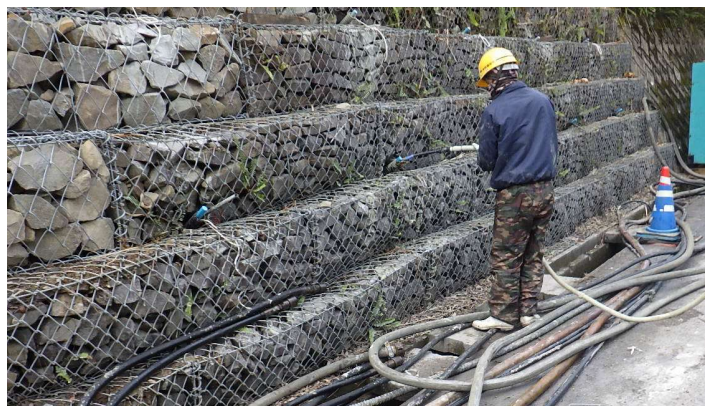
施工中 フトンカゴを受圧板代わりに使用しています。
