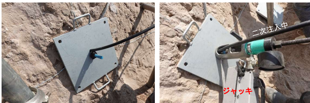
補強材を緊張した状態で二次グラウト注入
