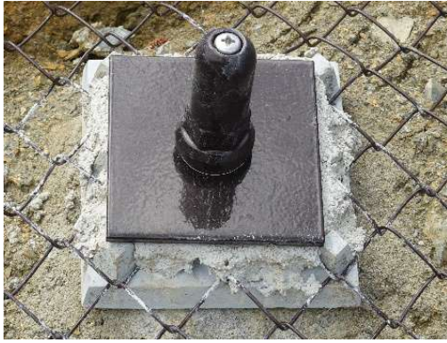
金網の固定状況
