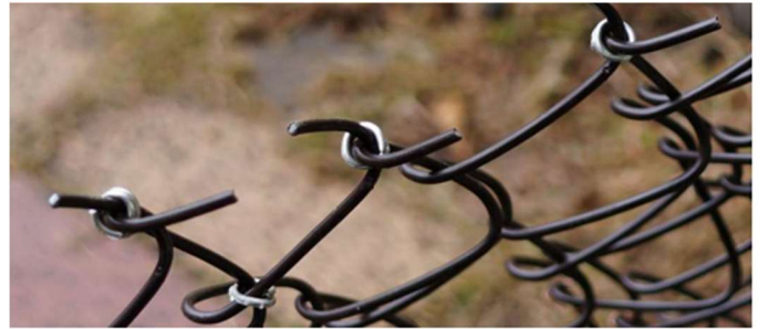
金網の端部結束状況
