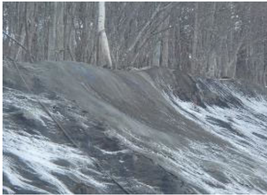
岩手県現場(雪が無いモルタルが施工箇所)
