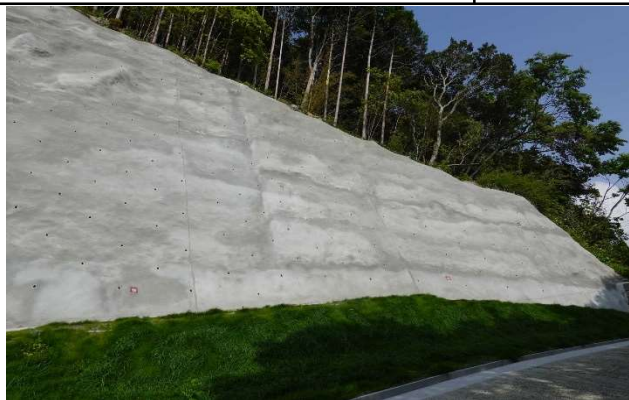
日置市 伊作田現場(モルタルの上に突出物が見えません)
