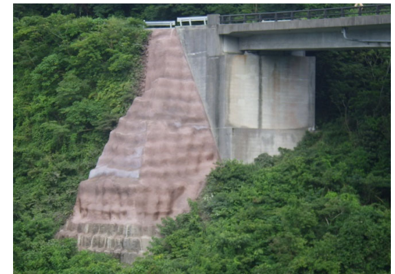
北薩地域振興局現場 大型土嚢積み上げた斜面の補強
