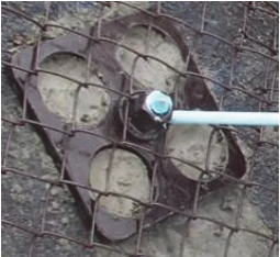
既設モルタル上に設置 この上にモルタル増設
