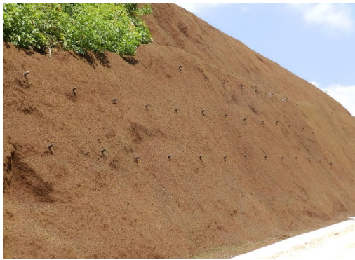
金山現場 植生基材吹付直後
