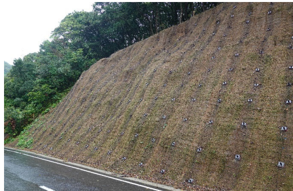
大泊現場工事直後 植生マット使用例
