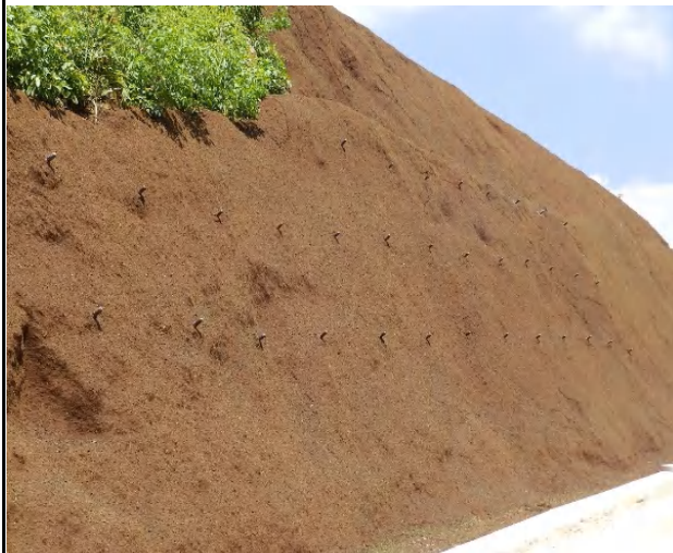
金山現場 植生基材吹付直後
