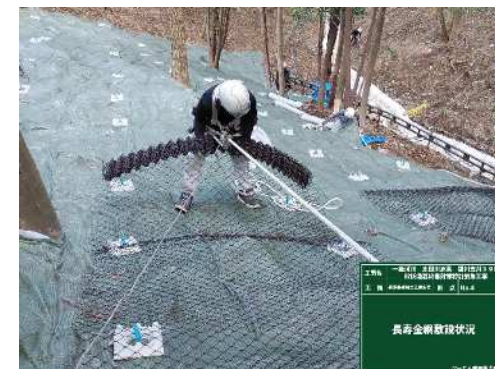
金網敷設中 1名の人力で敷設可能
