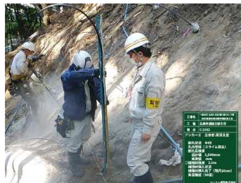
削孔と補強材挿入
