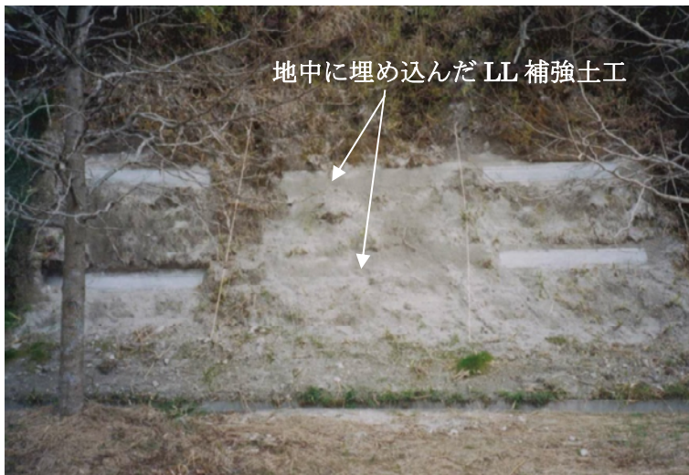
図-7 地中に設置されたLL補強土工法
