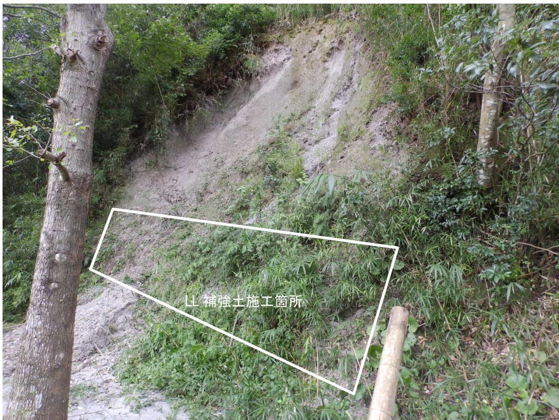
図-10 崩壊しなかった LL 補強土施工箇所（斜めから撮影）
