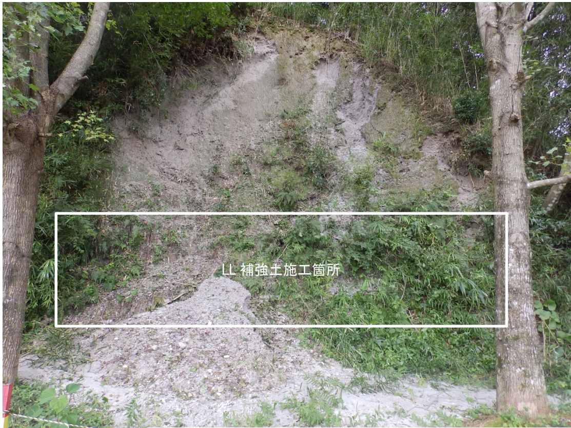
図-9 崩壊しなかった LL 補強土施工箇所（正面から撮影）
