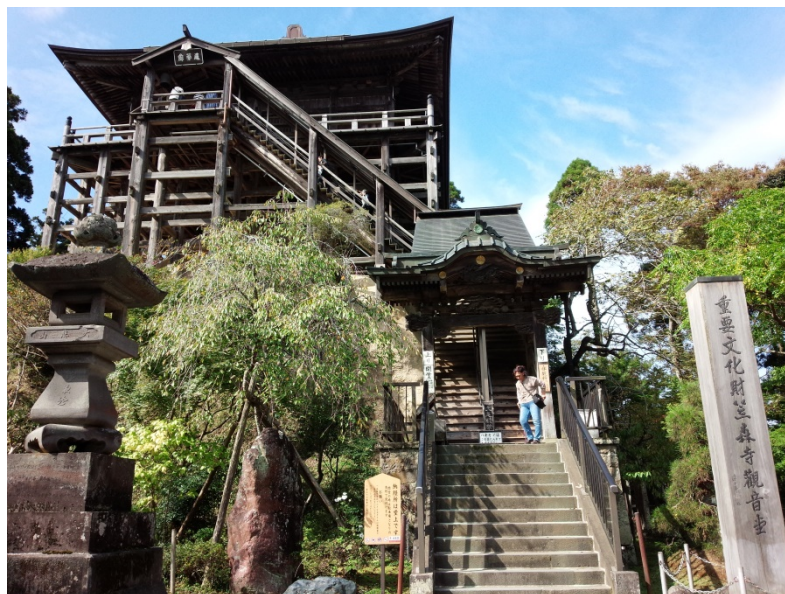
図-13 笠森寺（重要文化財）でもLL補強土工（基礎の補強）
