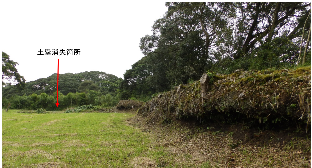
図-5 本丸の土塁消失箇所
