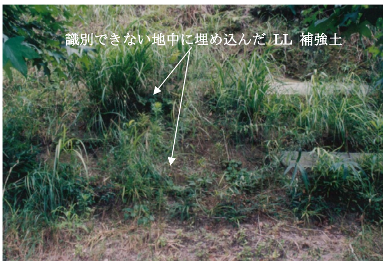
図-8 地中に設置されたLL補強土工法
