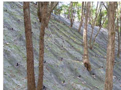
金網敷設後 樹木を残した施工後の状況
