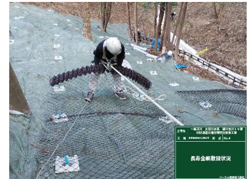
金網敷設中 1名の人力で敷設可能
