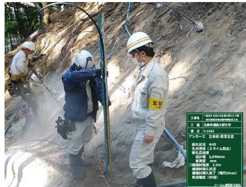
削孔と補強材挿入
