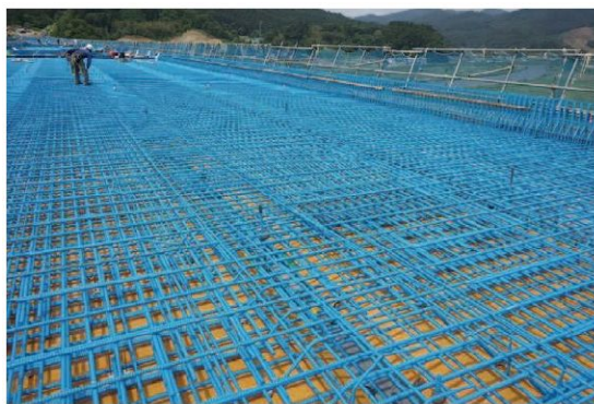
エポキシ樹脂塗装鉄筋の工事現場
