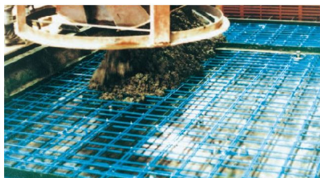
本州四国連絡橋公団殿 南北備讃瀬戸大橋（PC/バネル）
