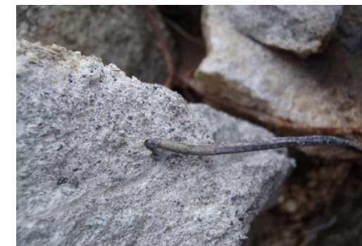
図-15 吹付モルタル内部のメッキ金網の腐食
