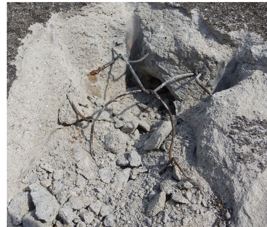
図-15 吹付モルタル内部のメッキ金網の腐食
