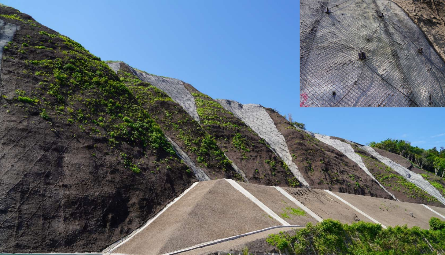
DC ネット工法（他社製品） 能登国道 249 号
