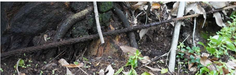
図-8 亜鉛アルミニウム合金メッキロープの腐食 25 年経過
