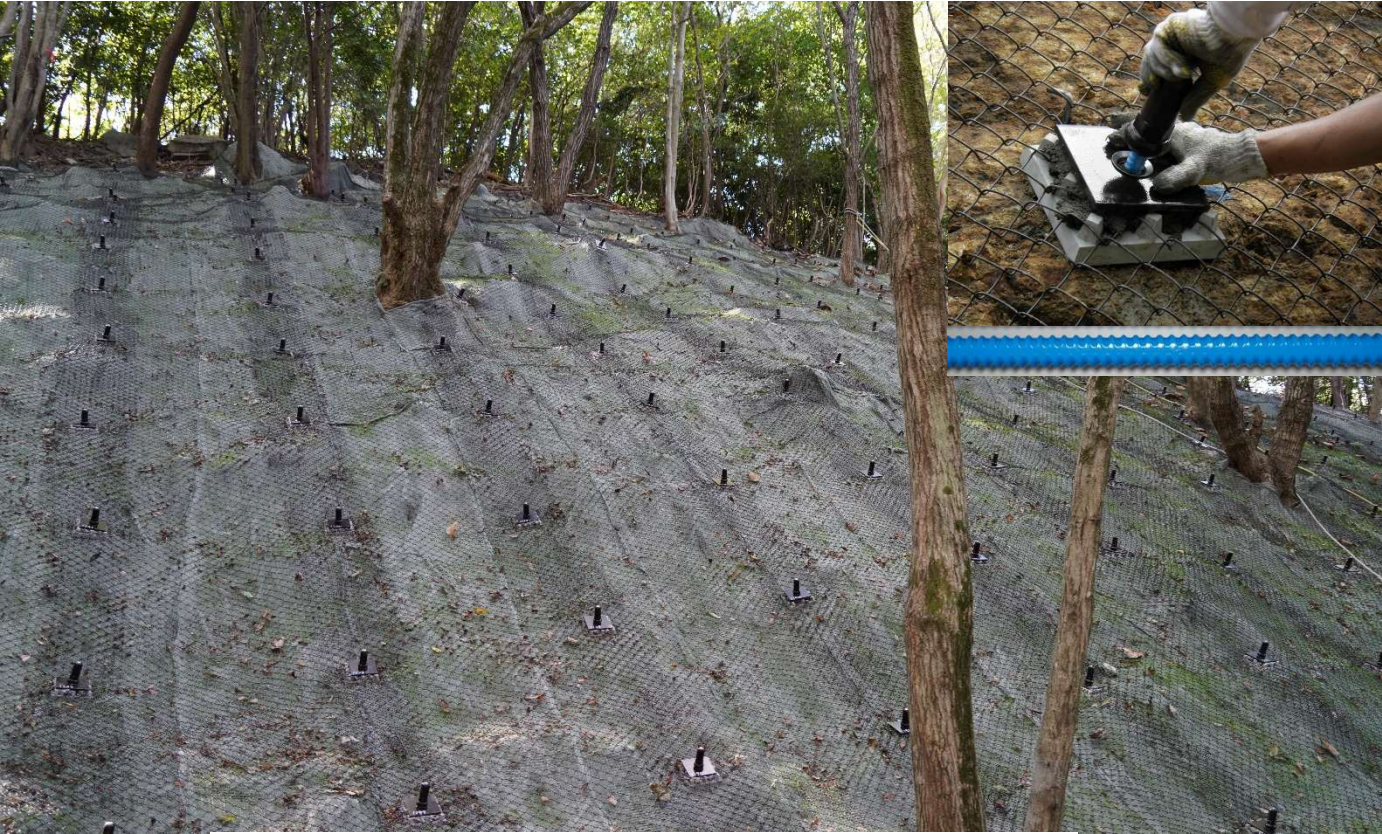
長寿命補強土植生型 & 長寿金網防護工（長寿補強土）
