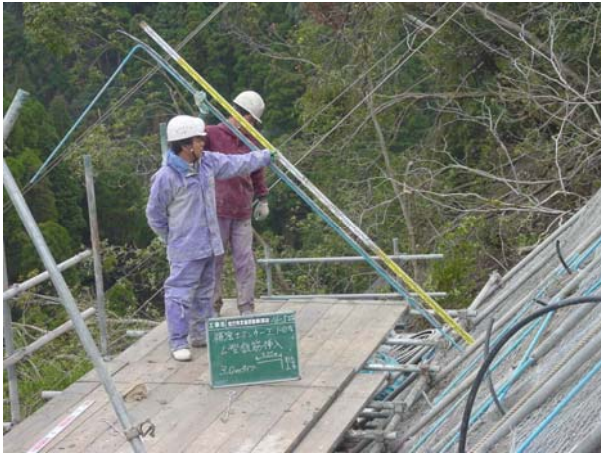
図-4.4 足場からの補強材挿入
