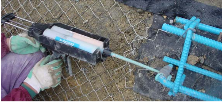
図-4.13 ダブルカートリッジ方式による専用注入ガンの使用状況
