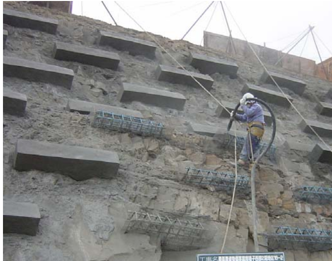
図-4.6 吹付モルタルによるエルックの造成
