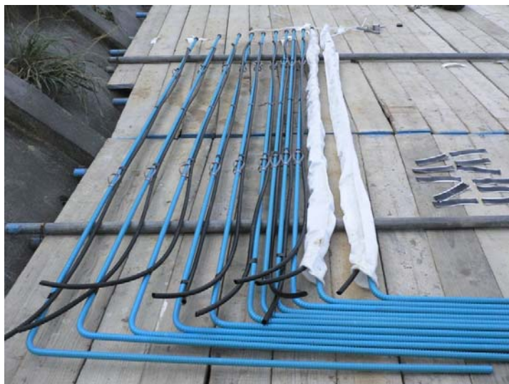
図-4.3 パッカーを使用した注入(右側2本がパッカーセット後)
