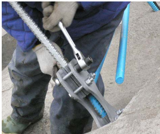
図-4.7 エポキシ樹脂塗装鉄筋をつかむLLホルダー(灰色)とテンションバー(銀色)
