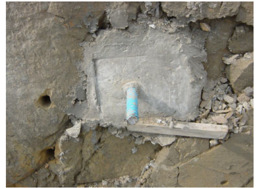
図-4.9 補強鋼材切断状況
