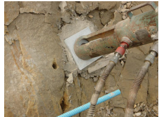
図-4.10 仮切断法での試験状況
