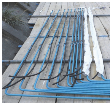
補強材（挿入直前の状況）
