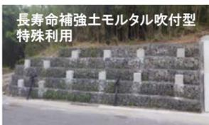
類を見ない超耐久性の補強土。エポキシ樹脂塗装鉄筋 (D25) が、波型のポリエチレン管の内部に全長挿入され、管の内部も地盤との間もすべてグラウトする。ポリエチレン管内部の補強材は、数世紀を経ても錆びることは無いだろう。
