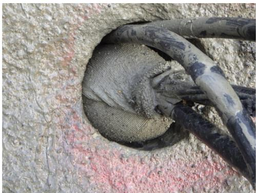
パッカーにセメントミルクを充填した状況。挿入鋼材が重いと、挿入中にパッカーが破れやすくなる。この点でも、軽量の補強材は優れている。
