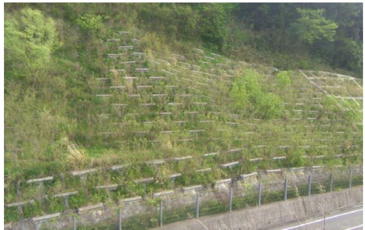
図-12 変状が発生したのり枠の補修事例
